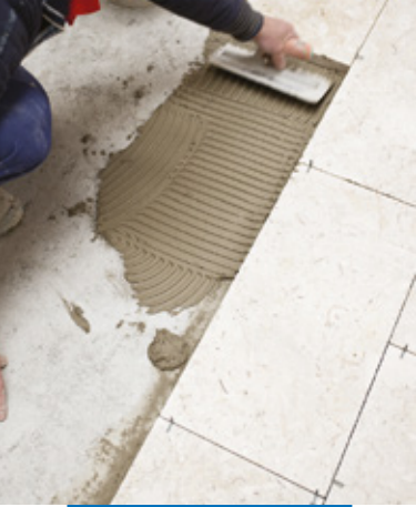
Verklebung von Keramikfliesen mit Keraflex Maxi S1 zero grau
