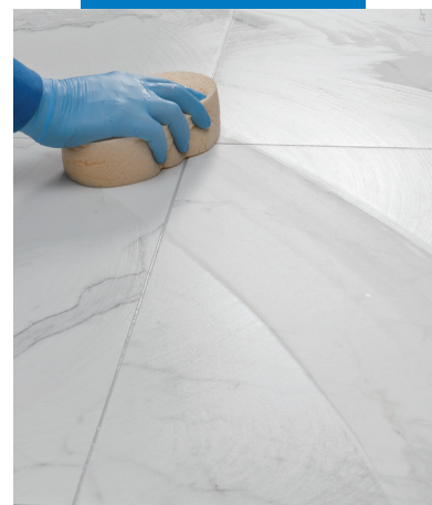
Endreinigung des Fugenmörtels mit einem Schwamm
