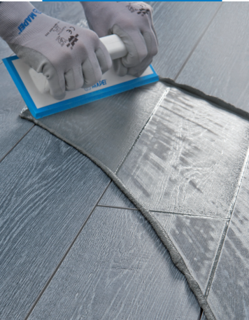
Verfugung eines Bodenbelags mit Holzoptik mit Ultracolor Plus mittels Gummifugbrett
