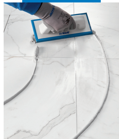
Verfugung eines Feinsteinzeugbo- denbelags mit Marmoroptik mit Ultracolor Plus mittels Gummifugbrett
