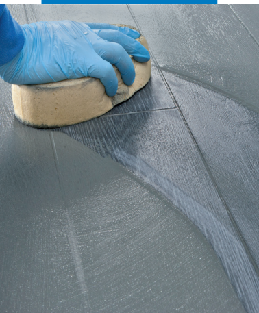
Endreinigung des Fugenmörtels mit einem Schwamm
