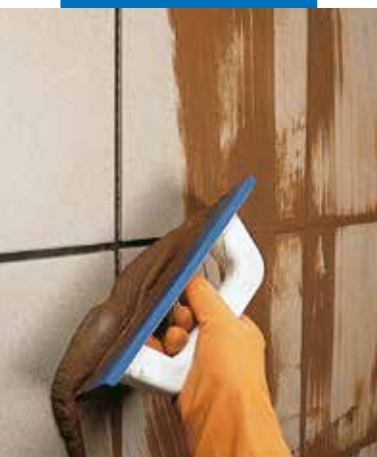
Ausfugen einer Außenwandbekleidung mit einer Fugscheibe
