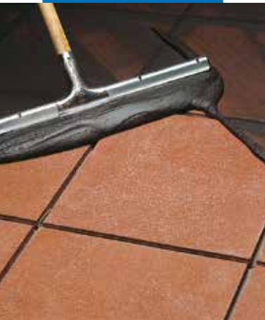
Einschlämmen eines Cotto-Belages
