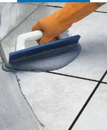
Einfugen eines Keramikbelages mit einer Gummifugscheibe
