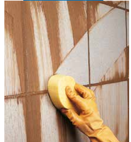
Reinigen des Wandbelages mit einem Schwamm
