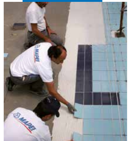
Verlegung keramischer Fliesen in einem Schwimmbecken auf eine Abdichtungsschicht aus Mapelastic
