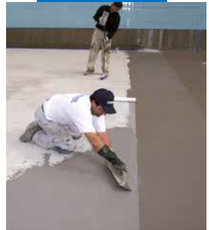
Abdichtungsarbeiten an einem Schwimmbecken mit Mapelastic
