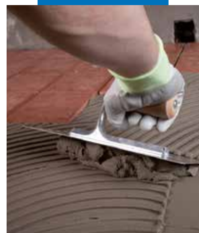
Auftrag von Granirapid auf einer mit Mapelastic abgedichteten Terrasse
