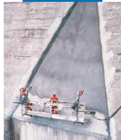
Beispiel einer Sprühapplikation von Mapelastic auf einem Dammbauwerk
