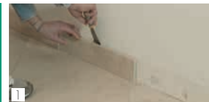
1 Eliminare il battiscopa Remove skirting
