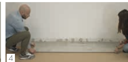
4 Posare il pavimento senza fuga Lay the floor tiles without close joints
