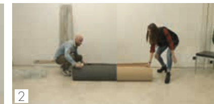
2 Stendere il tappetino Lay the underlayer
