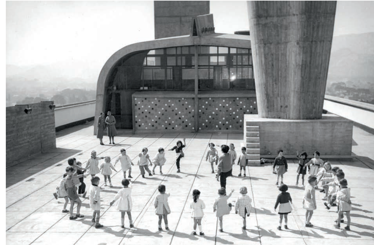
Unite d'Habitation - Marseille - 1945 ©
