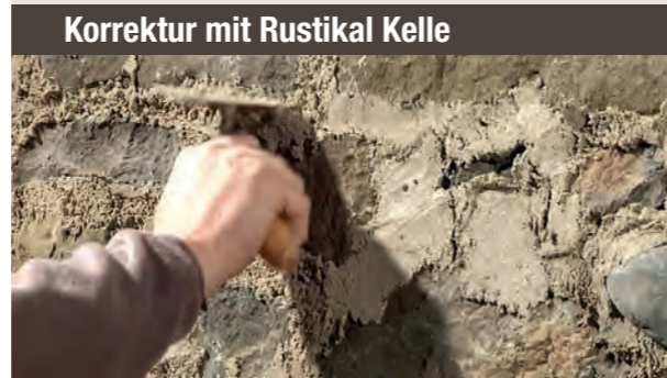
Korrektur mit gedrückter Rundspachtel
