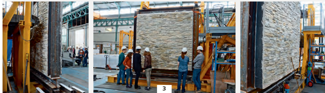
muregeopietra auf Betonbausteinen
