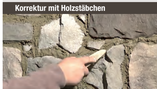
Endbearbeitung mit Schnittkante
