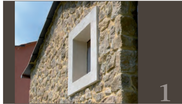
Fensterumrandung mit gespachteltem und eingefärbtem Rahmen
