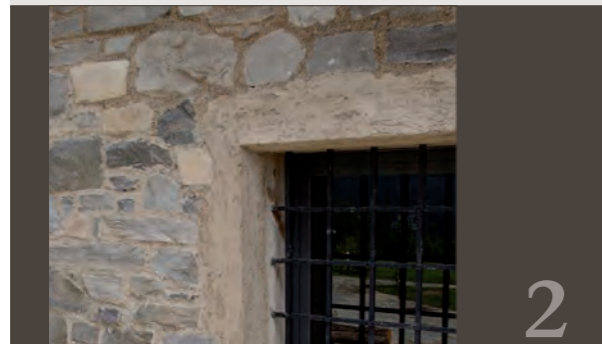
Fensterumrandung mit flächenbündig versenkten Steinen
