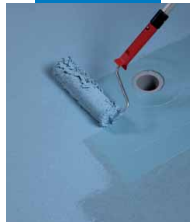
Auftragen einer zweiten Schicht Mapelastic® AquaDefense mit der Rolle
