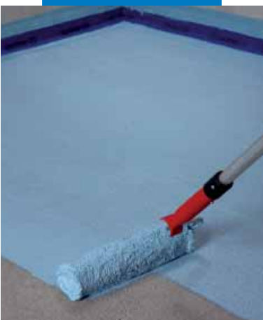
Abdichtung von Terrassen mit 1. Schicht Mapelastic® AquaDefense
